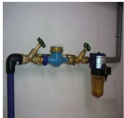
Hausanschluss aus PE
